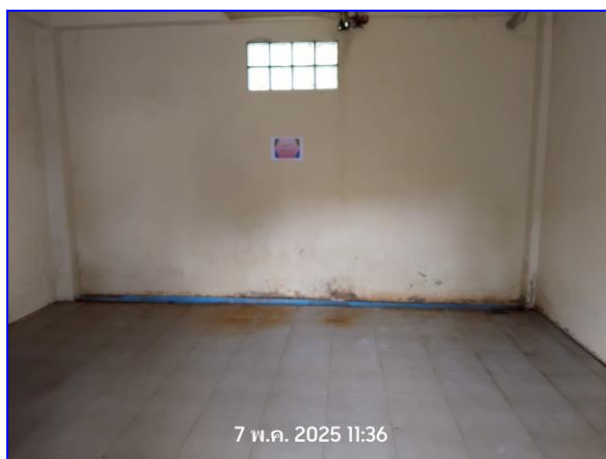
รูปที่ 2.10 ราระบายน้ำเสียจากห้องพักขยะลงสู่ระบบบำบัด
