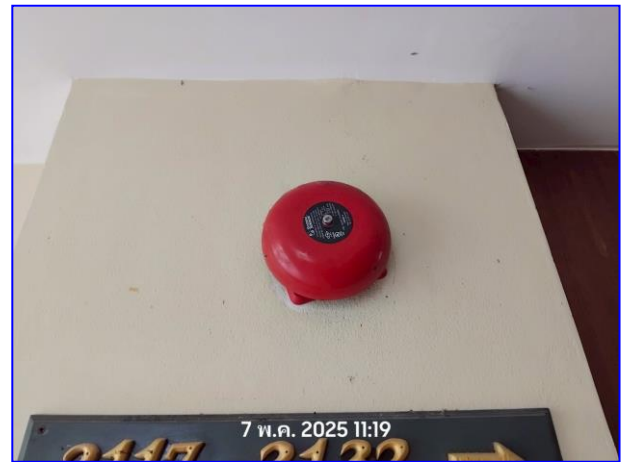
รูปที่ 2.16 Alarm Bell (อุปกรณ์เตือนภัยด้วยเสียง)
