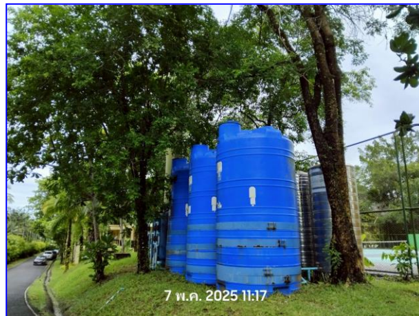
รูปที่ 2.40 ถังกรองน้ำชนิด Multimedia filter
